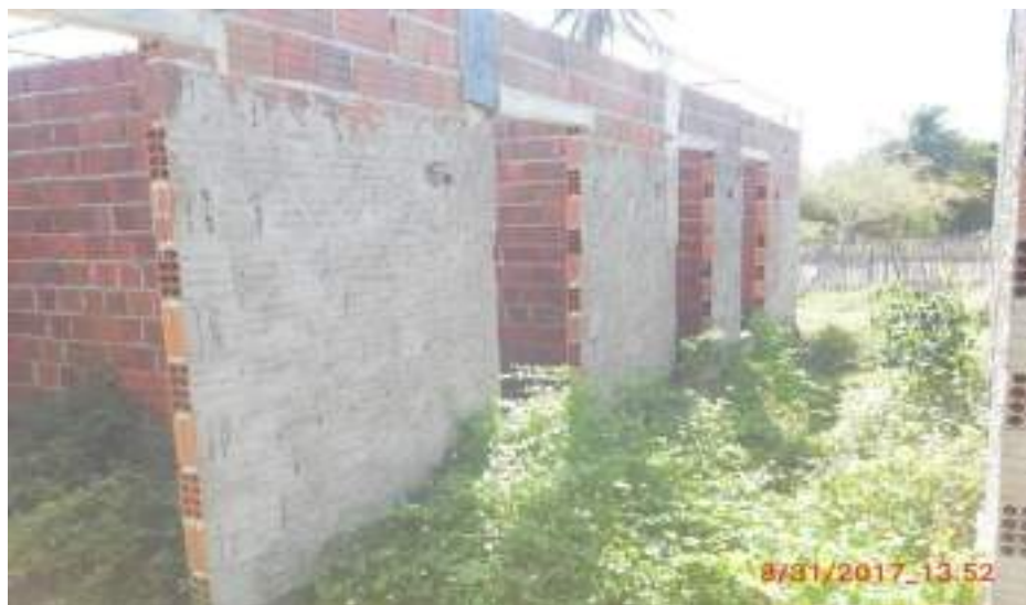
FOTO 05: SITUAÇÃO ATUAL DO REVESTIMENTO (CHAPISCO) NA ALVENARIA DA UBS BAIXA DO QUINQUIM
