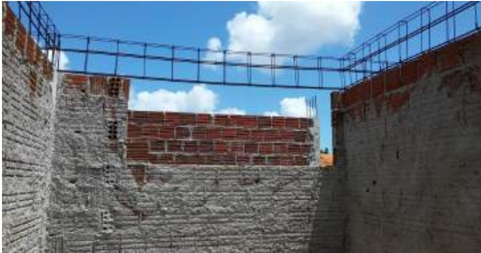
FOTO 02 – SITUAÇÃO DE VIGAS, VERGAS ALVENARIA E REVESTIMENTO DA UBS DE SANTA LUZIA
