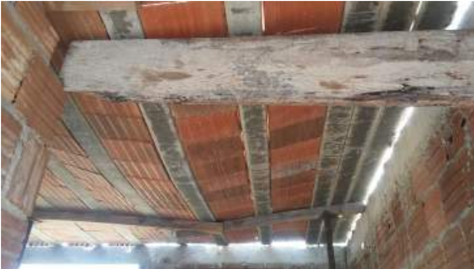
FOTO 09 – SITUAÇÃO ATUAL DA LAJE NA UBS PONTA DO CALCANHAR
