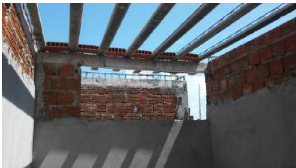
FOTO 15 – SITUAÇÃO DA LAJE (INCOMPLETA) DA UBS PONTA DO CALCANHAR
