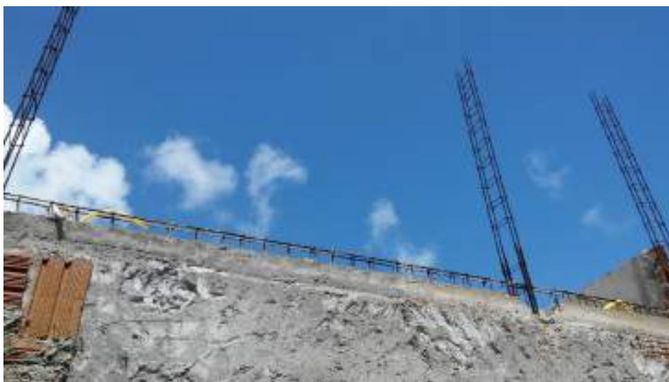
FOTO 07 – FERRAGENS ESTRUTURAL ESPOSTA NA UBS ESQUINA DO BRASIL
