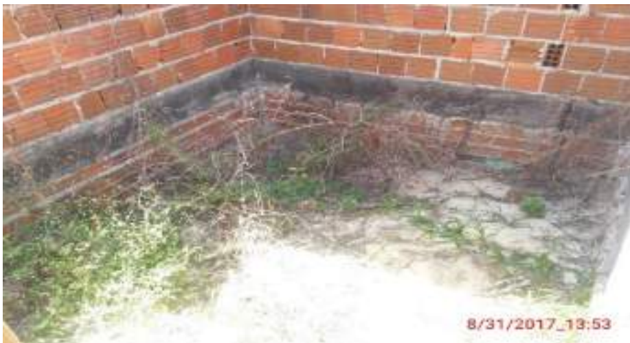
FOTO 09: FALTA DE IMPERMEABILIZAÇÃO NO BALDRAME DA UBS BAIXA DO QUINQUIM
