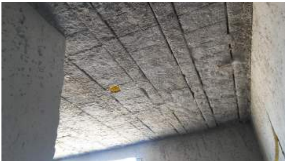
FOTO 04 – SITUAÇÃO ATUAL DE ALGUMAS LAJES CHAPISCADAS
