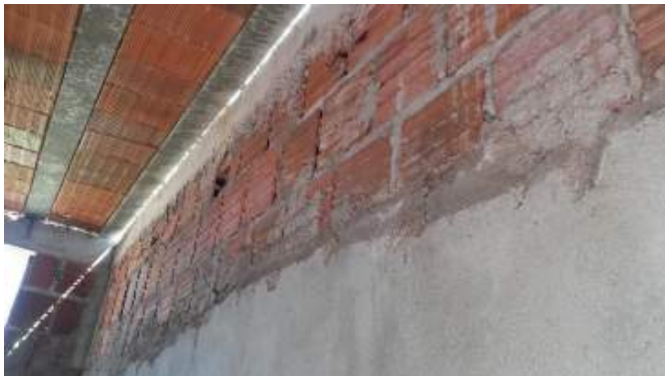
FOTO 05 – SITUAÇÃO ATUAL DO REVESTIMENTO DA ALVENARIA NA UBS PONTA DO CALCANHAR
