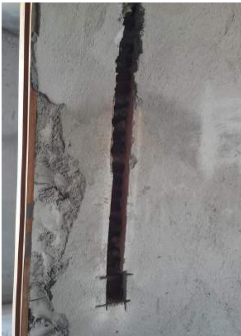
FOTO 08 - ALGUNS RASGOS NA PAREDE EXECUTADOS NA UBS ESQUINA DO BRASIL
