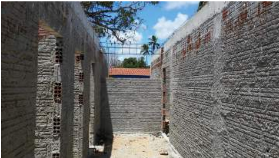
FOTO 05 – SITUAÇÃO ATUAL DAS PAREDES, VIGAS DA PARTE INTERNA DA UBS DE SANTA LUZIA
