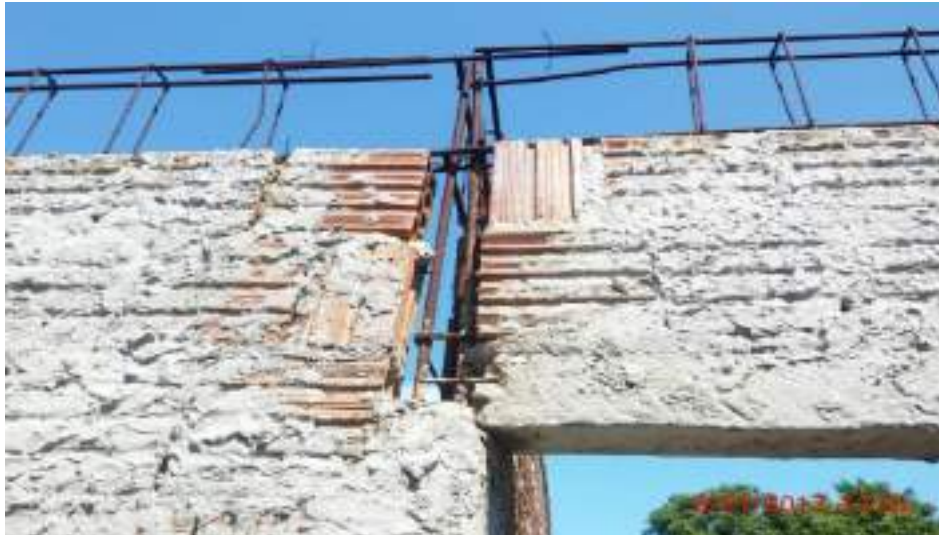
FOTO 08: SITUAÇÃO DE UM ELEMENTO ESTRUTURAL (ENCONTRO DA VERGA COM O PILAR) MAL EXECUTADO NA UBS BAIXA DO QUINQUIM
