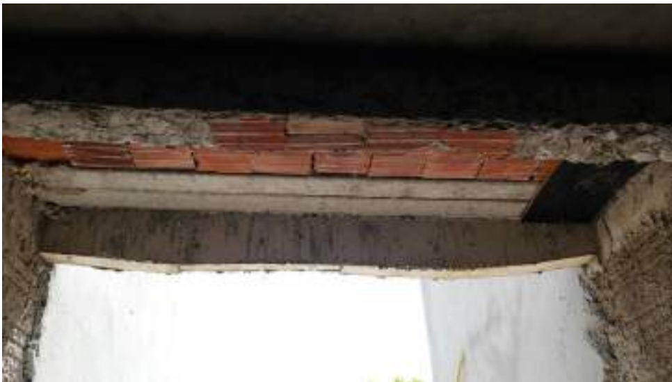
FOTO 10 – SITUAÇÃO ATUAL DE UM ELEMENTO ESTRUTURAL (VIGA) MAL EXECUTADA NA UBS ESQUINA DO BRASIL
