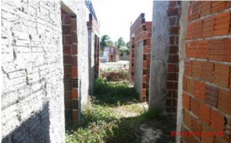
FOTO 06: SITUAÇÃO ATUAL DA ALVENARIA (INCOMPLETA) DA UBS BAIXA DO QUINQUIM
