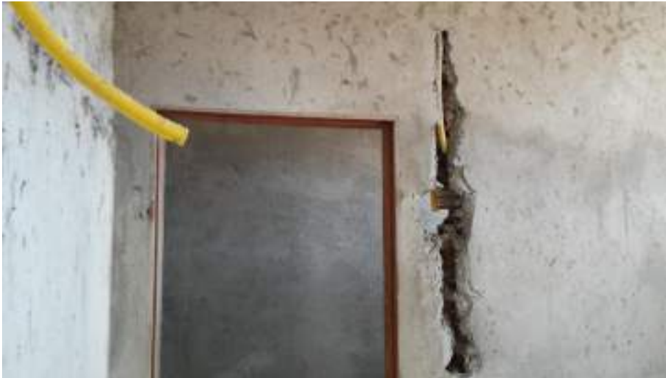
FOTO 11 – RAGOS NA PAREDE JÁ EXECUTADOS NA UBS ESQUINA DO BRASIL
