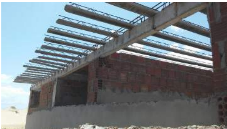
FOTO 02 – SITUAÇÃO DA LAJE PARCIAMENTE EXECUTADA DA UBS PONTA DO CALCANHAR
