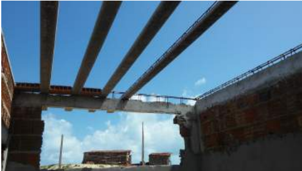
FOTO 03 – SITUAÇÃO DA LAJE PARCIALMENTE EXECUTADA DA UBS PONTA DO CALCANHAR
