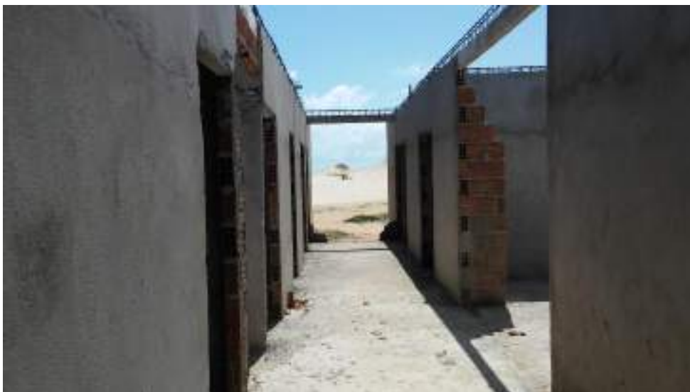
FOTO 04 – SITUAÇÃO ATUAL DA ALVENARIA, DO PISO, VIGAS E COBERTURA DA UBS PONTA DO CALCANHAR
