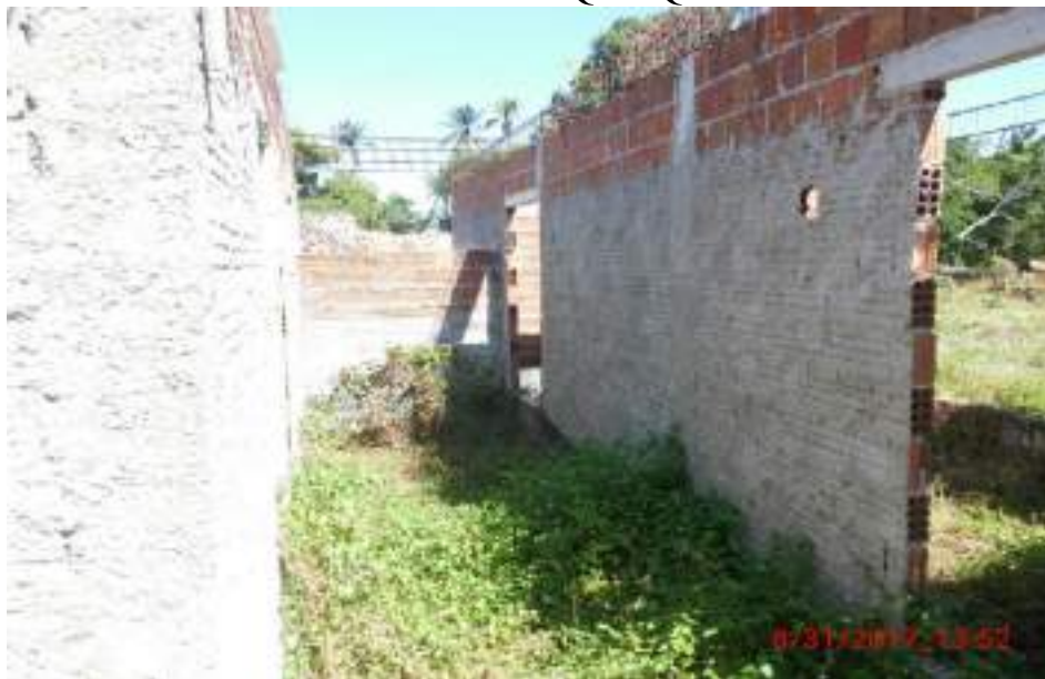
FOTO 04: SITUAÇÃO ATUAL DA ALVENARIA E VIGAS (INACABADAS) DA UBS BAIXA DO QUINQUIM
