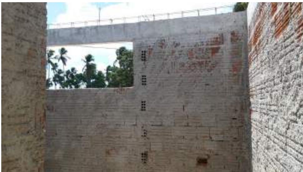
FOTO 03 – SITUAÇÃO DE ALVERAIA NA UBS DE SANTA LUZIA
