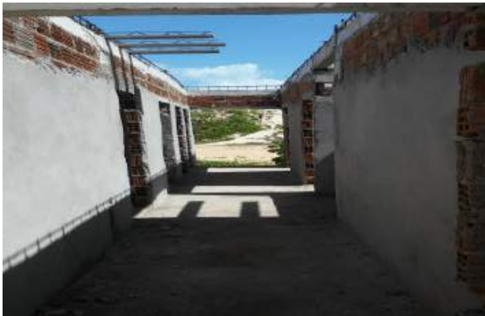
FOTO 14 – SITUAÇÃO DA ALVENARI E LAJE NA PARTE INTERNA DA UBS PONTA DO CALCANHAR
