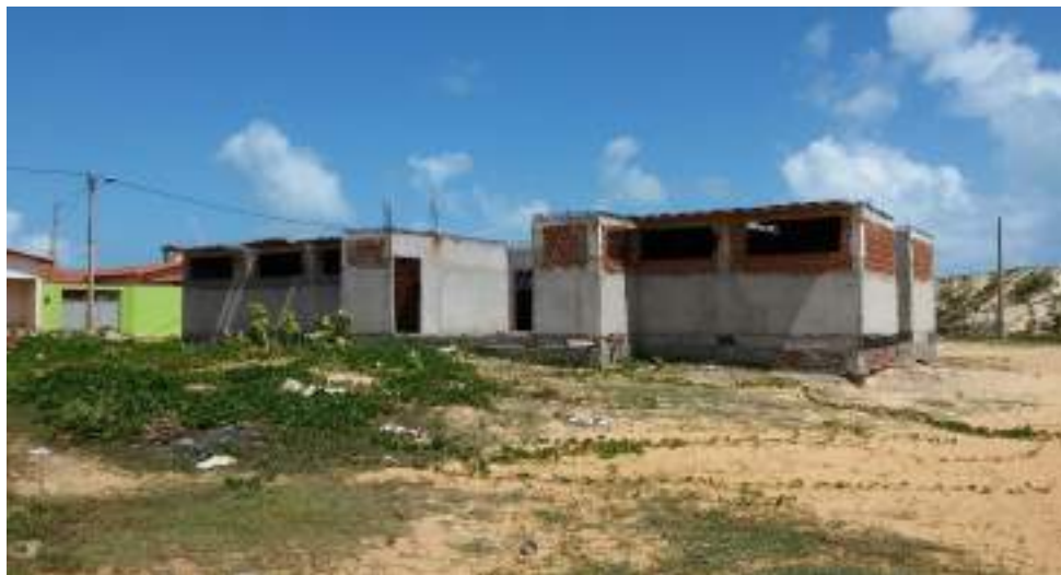
FOTO 01 – SITUAÇÃO ATUAL DA FACHADA DA UBS PONTA DO CALCANHAR
