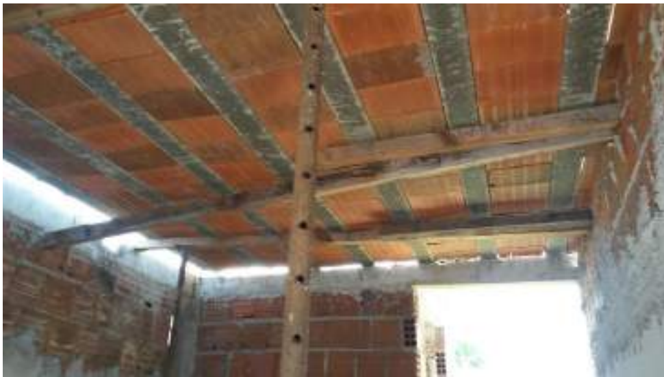
FOTO 12 – SITUAÇÃO ATUAL DAS ESCORAS E LAJE DA UBS PONTA DO CALCANHAR
