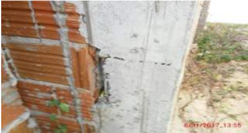
FOTO 12: ELEMENTO ESTRUTURAL (PILAR) MAL EXECUTADO NA UBS BAIXA DO QUINQUIM
