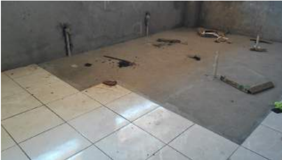
FOTO 09 – SITUAÇÃO ATUAL DO PISO (PARCIALMENTE ASSENTADO) NA UBS ESQUINA DO BRASIL
