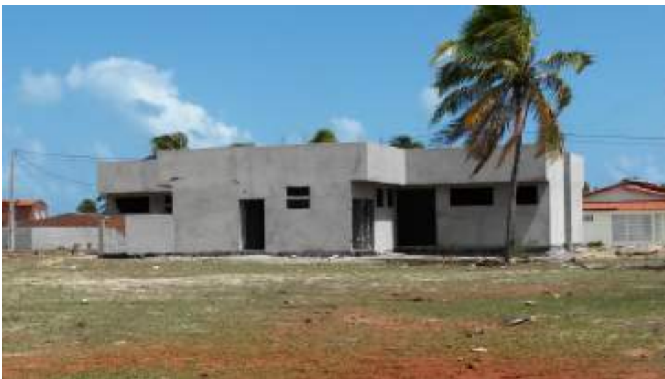
FOTO 12 – SITUAÇÃO ATUAL DA FACHADA DA UBS ESQUINA DO BRASIL
