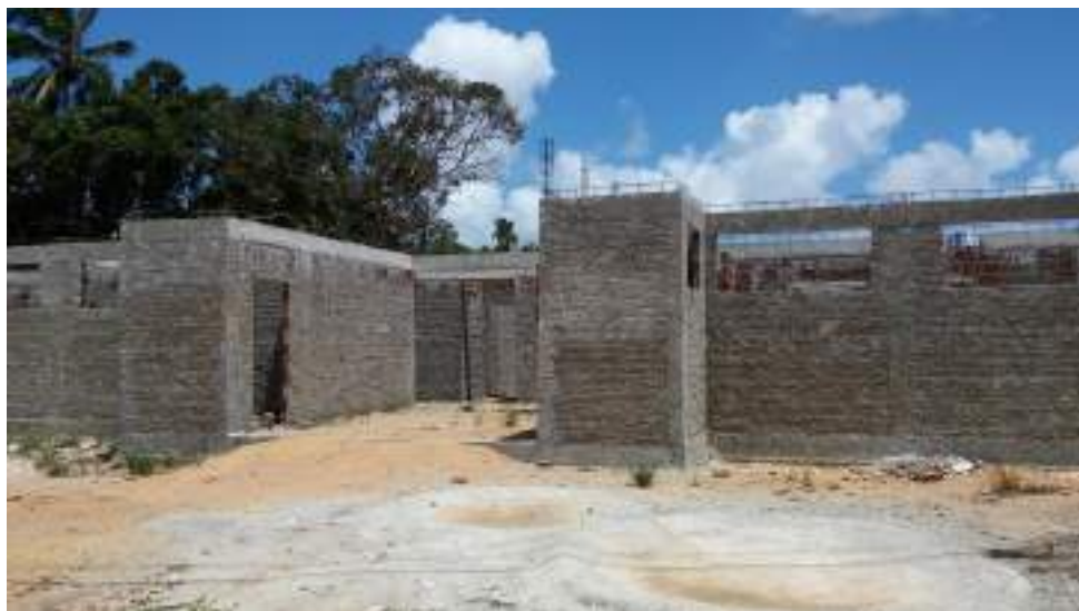
FOTO 01 – SITUAÇÃO ATUAL DA FACHADA DA UBS DE SANTA LUZIA
