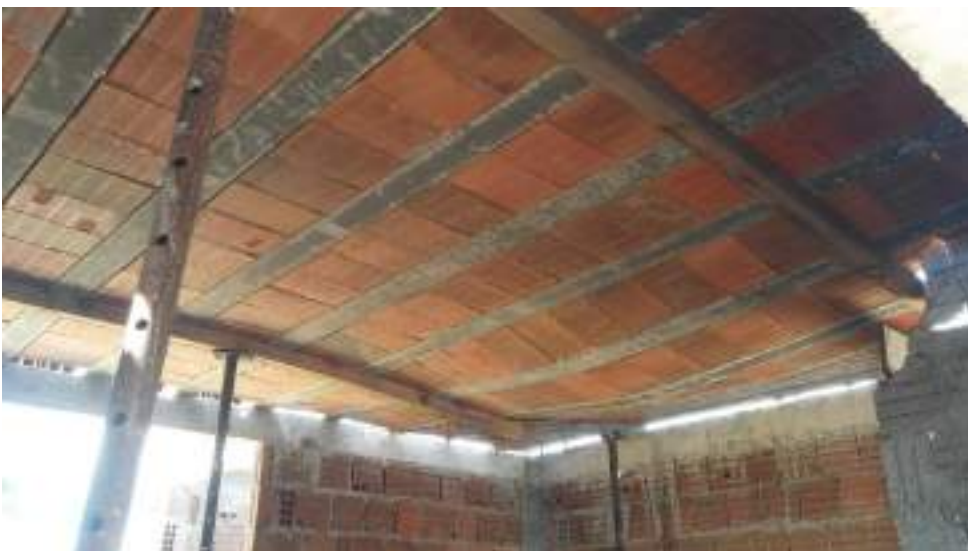
FOTO 10 – SITUAÇÃO ATUAL DA LAJE NA UBS PONTA DO CALCANHAR
