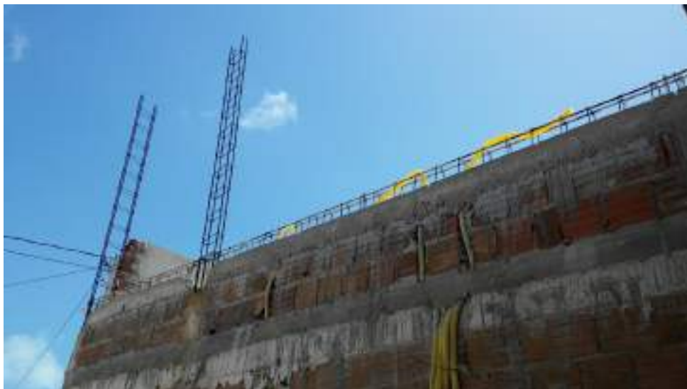
FOTO 06 – SITUAÇÃO ATUAL DE VIGAS E REVESTIMENTO NA ALVENARIA DA UBS ESQUINA DO BRASIL
