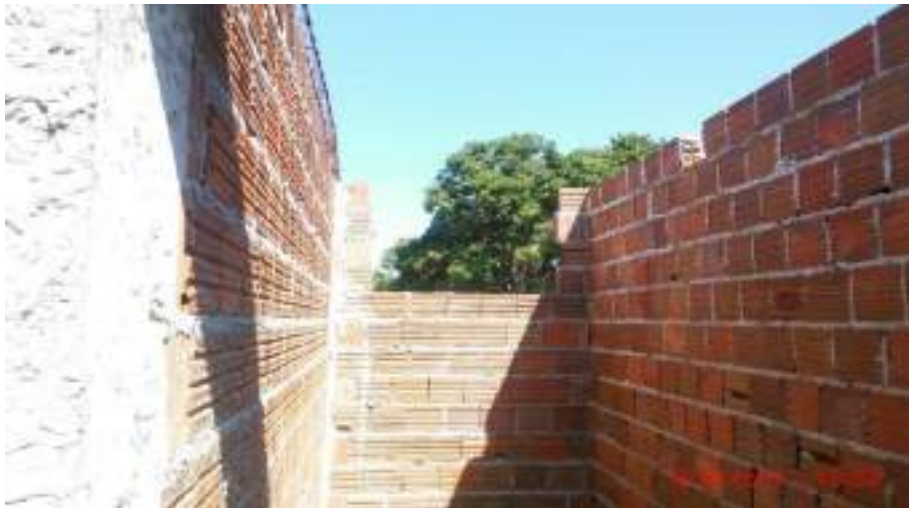
FOTO 07: SITUAÇÃO ATUAL DAS VERGAS E CONTRA VERGAS DA UBS
