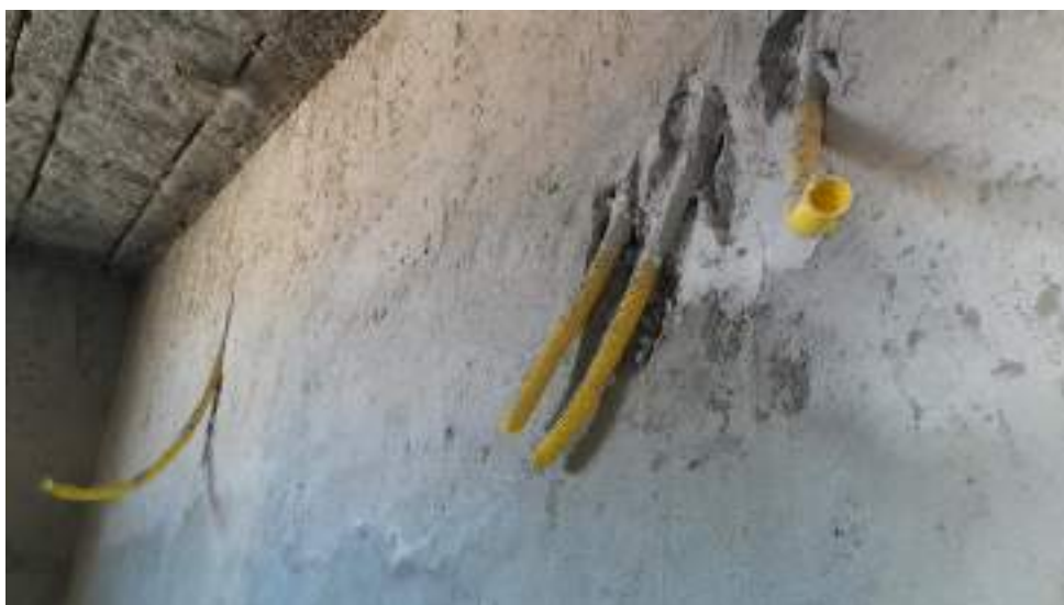
FOTO 05 – SITUAÇÃO ATUAL DE CONDUITES INSTALADOS NA UBS ESQUINA DO BRASIL
