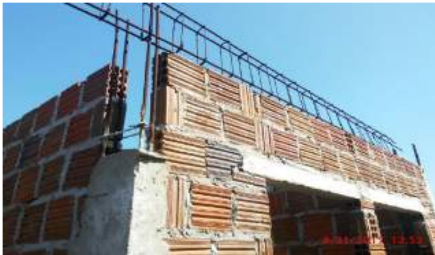
FOTO 11: ELEMENTO ESTRUTURAL (PILAR) INCOMPLETO NA UBS BAIXA DO QUINQUIM
