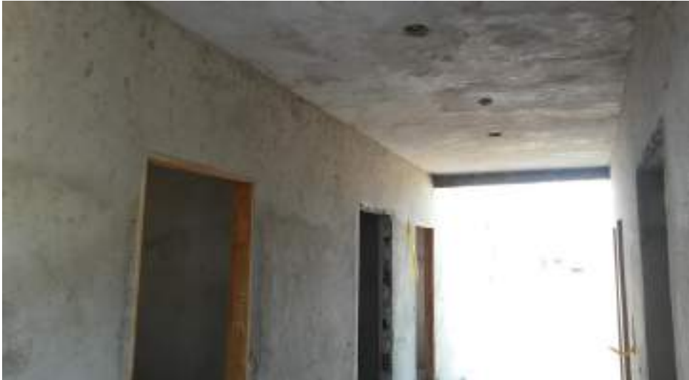
FOTO 02 – SITUAÇÃO ATUAL DAS ESQUADRIAS, REVESTIMENTO INTERNO E LAJE DA UBS ESQUINA DO BRASIL
