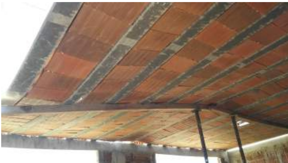
FOTO 08 – SITUAÇÃO ATUAL DA LAJE NA UBS PONTA DO CALCANHAR
