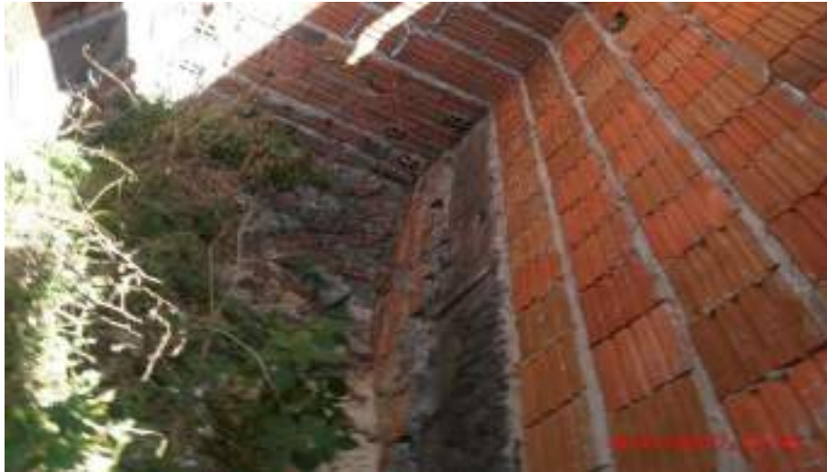
FOTO 10: FALTA DE IMPERMEABILIZAÇÃO NO BALDRAME DA UBS BAIXA DO QUINQUIM
