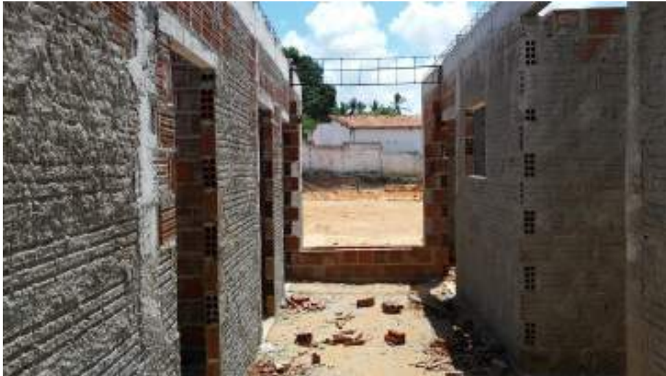
FOTO 04 – SITUAÇÃO ATUAL DE AMBIENTE INTERNO DA UBS DE SANTA LUZIA
