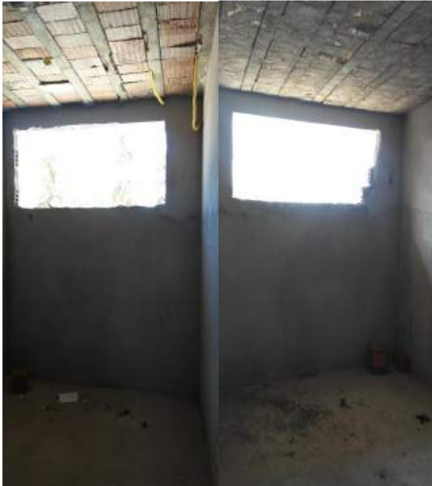
FOTO 03 – SITUAÇÃO ATUAL DE ALGUNS AMBIENTES INTERNOS DA UBS ESQUINA DO BRAISL
