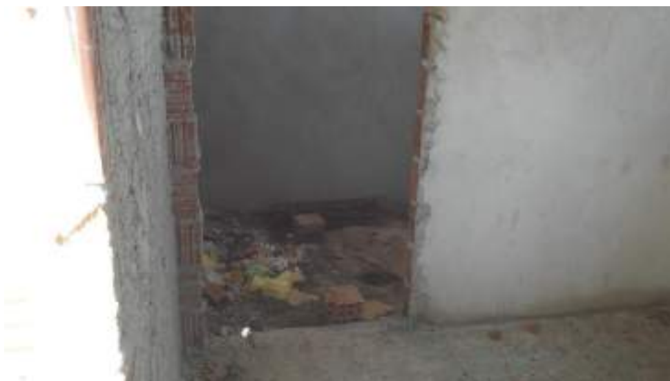
FOTO 06 – SITUAÇÃO DE AMBIENTE INTERNO DA UBS PONTA DO CALCANHAR DEVIDO AO ABANDONO
