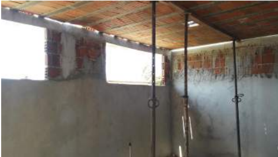
FOTO 07 – SITUAÇÃO DA LAJE E ESCORAS DA UBS PONTA DO CALCANHAR
