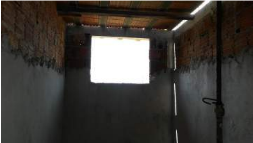
FOTO 11 – SITUAÇÃO DO REVESTIMENTO DAS ALVENARIAS DA UBS PONTA DO CALCANHAR
